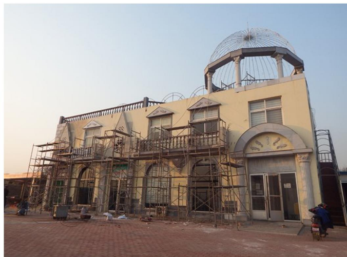
正在施工的办公楼立面改造
